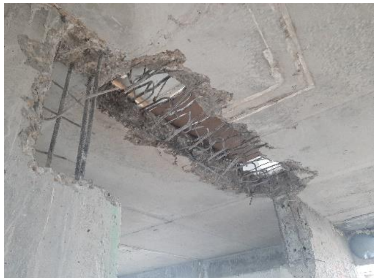
Foto 2 - doorgebroken plafond/vloerdeel:
