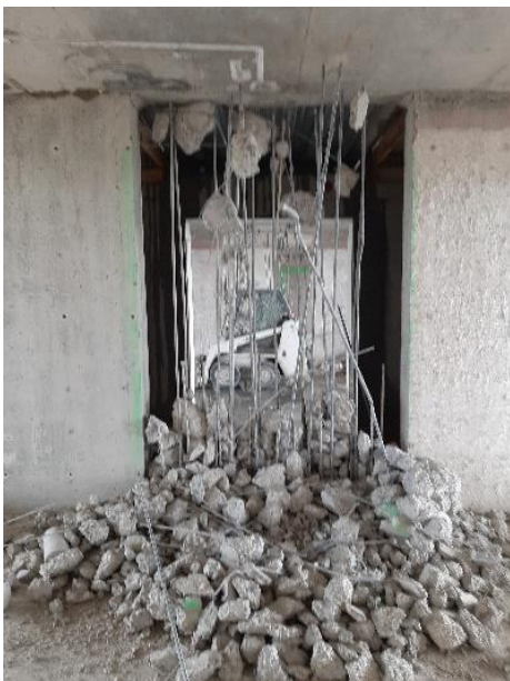
Foto 1 - doorgebroken wand:
