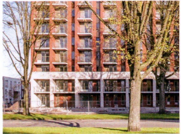
Stedelijk laag heeft een ander kleur dan de bebouwing daarboven Breehornapartementen, Amsterdam
