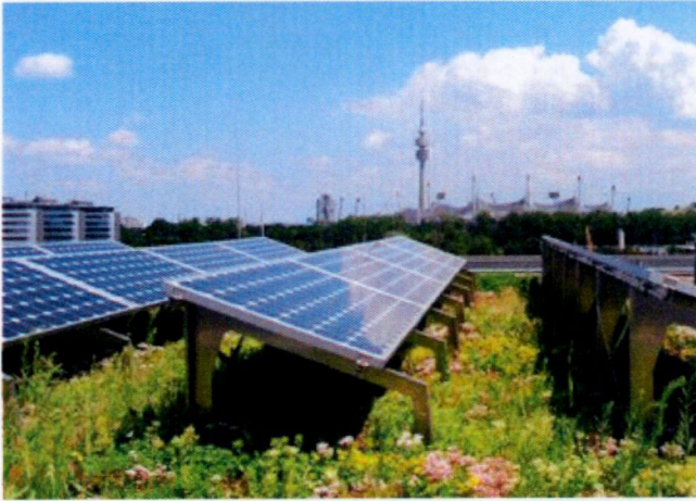
Dakoppervlak gebruikt voor groen en zonnepanelen.
