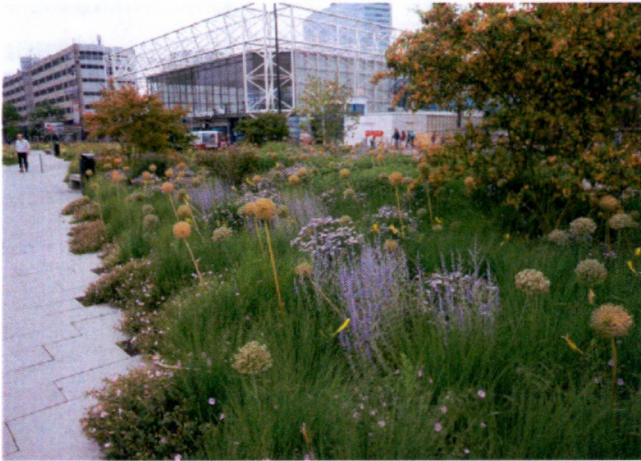
Publiek toegankelijk groen dak Orlyplein, Amsterdam
