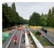
Aanleg WarmteLinQ door Rijswijk
