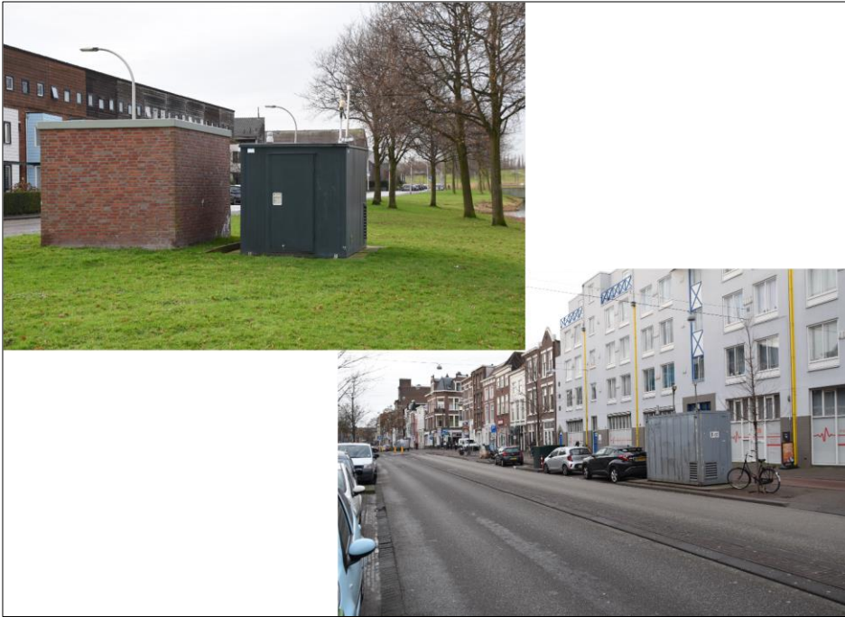
Figuur 2.1: LML-meetstation aan de Bleriotlaan in Ypenburg (links) en Vaillantlaan in Den Haag (rechts)
