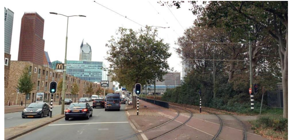
Figuur 4.4: Huidige tramsporen Lekstraat (kijkrichting vanaf Scheldeplein richting Den Haag Centraal).
