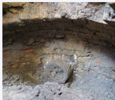
Tollensplein. Detail van de putwand. De gresbuis is op de foto goed zichtbaar.
